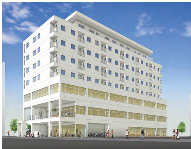
【事業主体】合同会社 米屋町東地区開発 【建築面積】約870㎡ 【整備内容】商業施設、デイサービス、サービス付き高齢者向け住宅 等 【竣工】平成29年度（予定）
