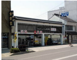
駐車場出入口 (国道406号から)
